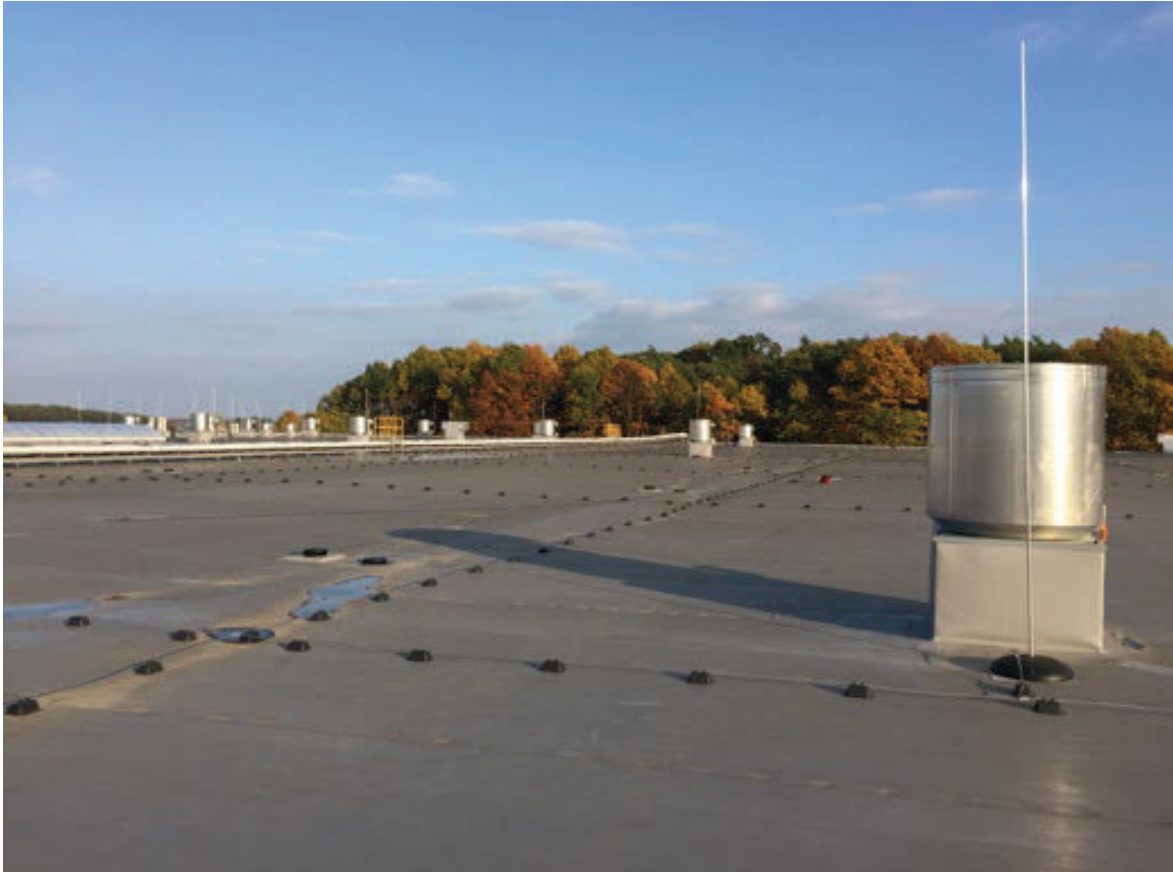
Bild: Dachbereich Wareneingangslager(Fa. Köhl GmbH)
